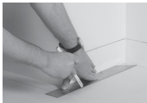
Nanieść podobną linię na podłogę.
