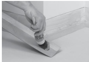
Nanieść klej na podłogę i ścianę między tymi liniami.
